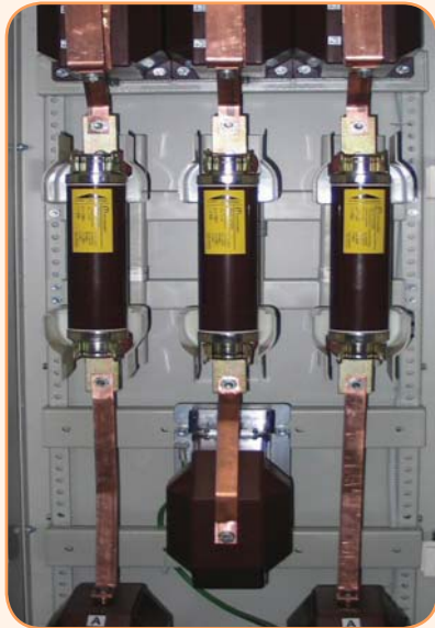
Внутренняя установка предохранителей
