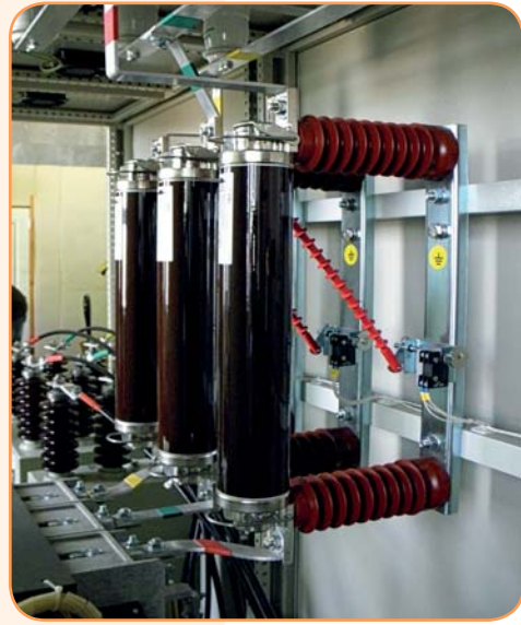
Установка внутренних держателей предохранителей*
